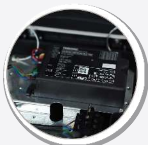
Compartimento del driver — placa de cableado extraíble
